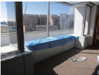
①床、壁をブルーシート、マスキングで養生をする。
