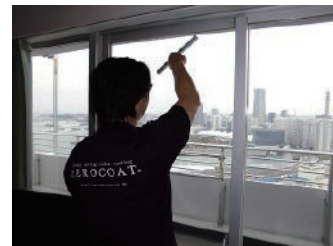
③マスキング後、ZEROCOATを専用塗装道具で塗装する。
